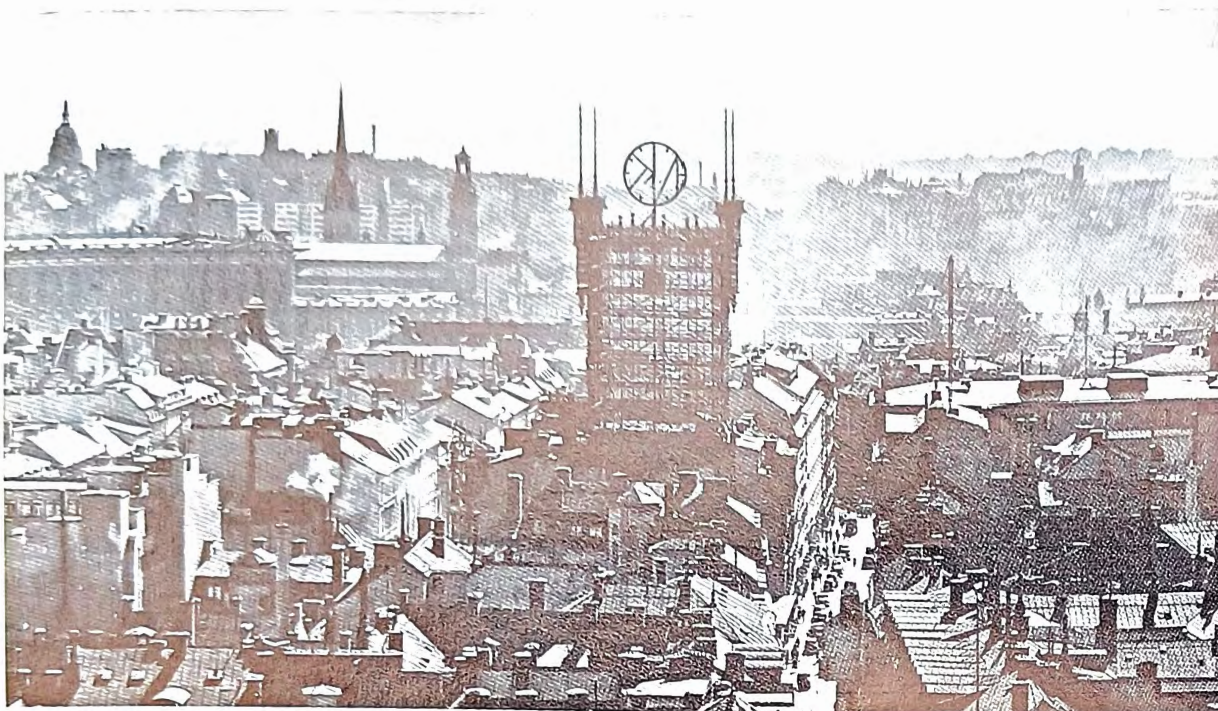
Telefontornet, som 1885—87 uppfördes på Allmänna telefonbolagets stationshus vid Malmskillnadsgatan, utgjorde en karakteristisk detalj i den stockholmska stadsbilden. Från tornets tusentals isolatorer gick de enkeltrådiga ledningarna ut till Allmännas många abonnenter. Sommaren 1952 härjades byggnaden av en eldsvåda som nödvändiggjorde att tornet revs.
