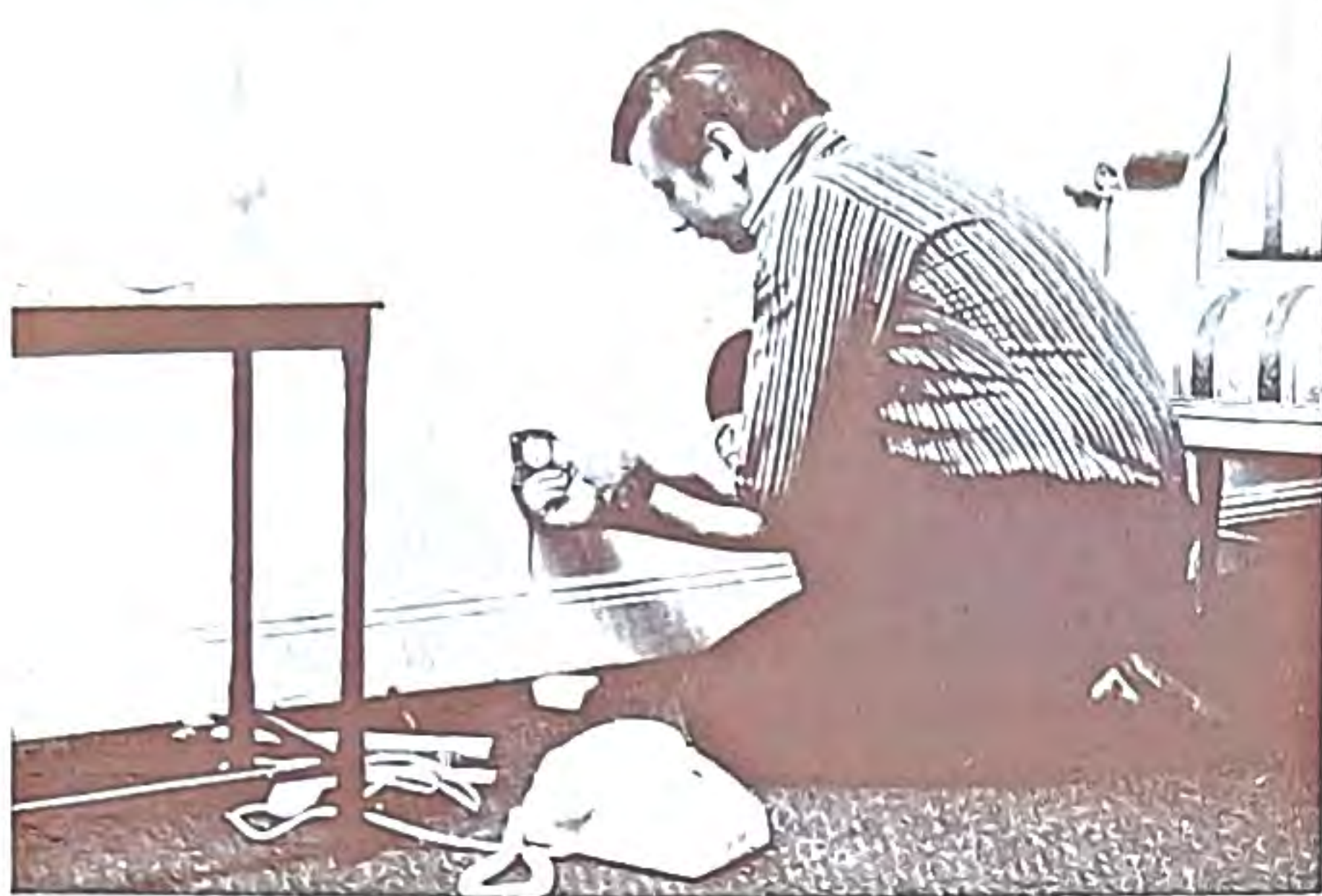
När en kund beställer en ny telefon eller flyttning av befintlig telefon, vill han naturligtvis i regel ha arbetet snabbt utfört. Men minst lika viktigt är att ett givet leveransbesked hålls.
