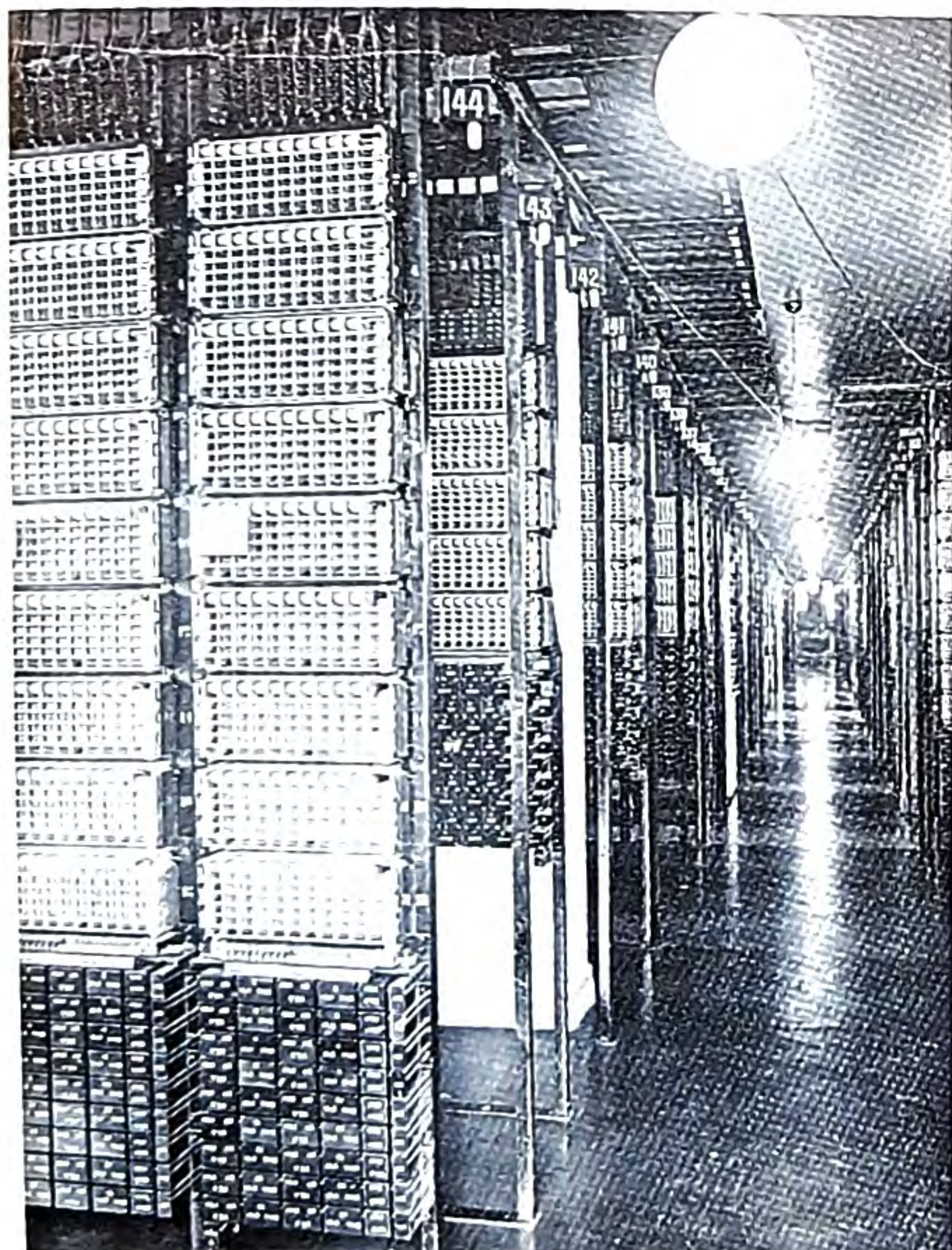
Världens största koordinatväljarstation byggdes i Malmö 1930–32. Här hade man moderniserat tekniken och bl. a. monterat väljarna med horisontella stänger.
